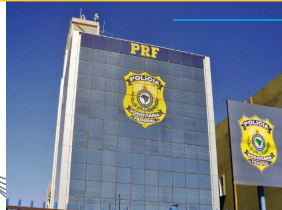
Edifício comercial executado em estrutura mista de concreto armado e estrutura metálica. Fachada com película de vidro e ACM. Salas com isolamento acústico e auditório para 50 lugares com tratamento acústico. Rede frigorígena com 40 máquinas do tipo Split. Infraestrutura de cabeamento estruturado, com CPD (Centro de Processamento de Dados).
